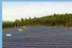
Central Fotovoltaica Riba d'Ave
